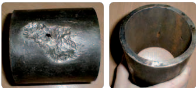
Obr. 1 Dôsledok pôsobenia bludných prúdov na ocelové potrubie
